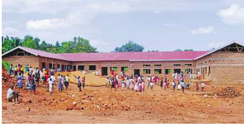
Das Gebäude der Grundschule nach Fertigstellung des Rohbaus
